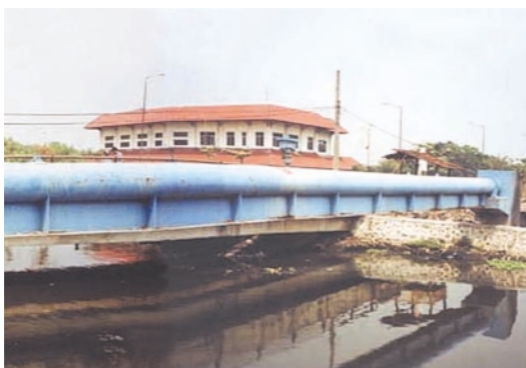
本事業により敷設された導水管
