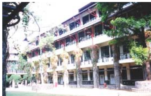
本事業により新築された校舎（5号館）
