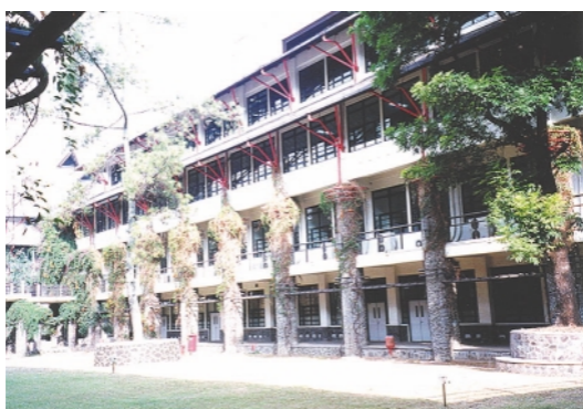
本事業により新築された校舎（5号館）
