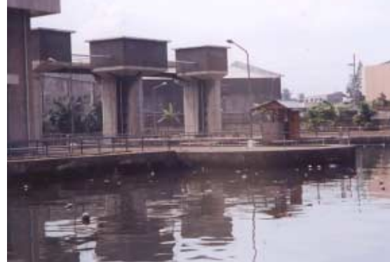
ピタス ポンプ場
