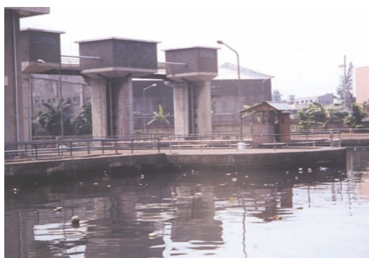
ピタス ポンプ場
