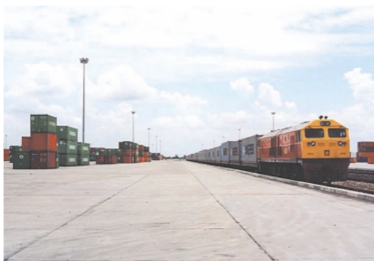
ラカバン駅内陸コンテナターミナル
