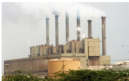
ビンカシム火力発電所
