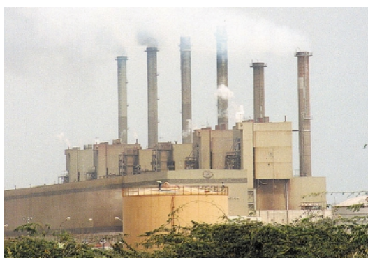
ピンカシム火力発電所
