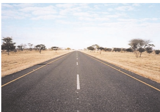
本事業にて建設されたカラハリ道路
