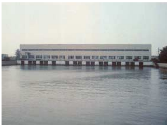
取水ポンプ場（天津）
