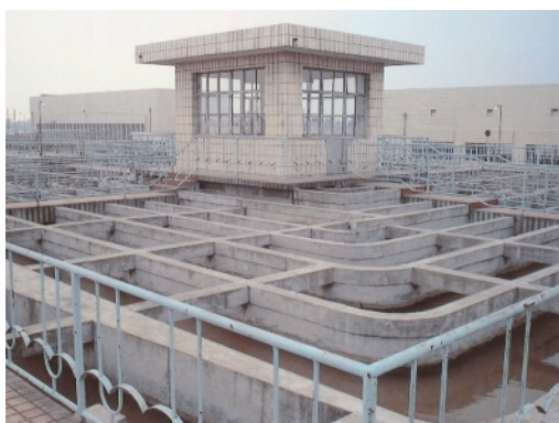
緩速濾過槽(南京)
