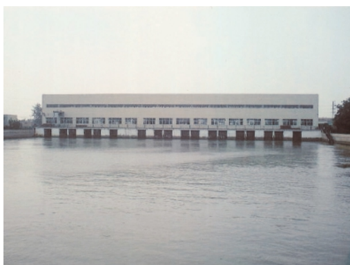
取水ポンプ場(天津)
