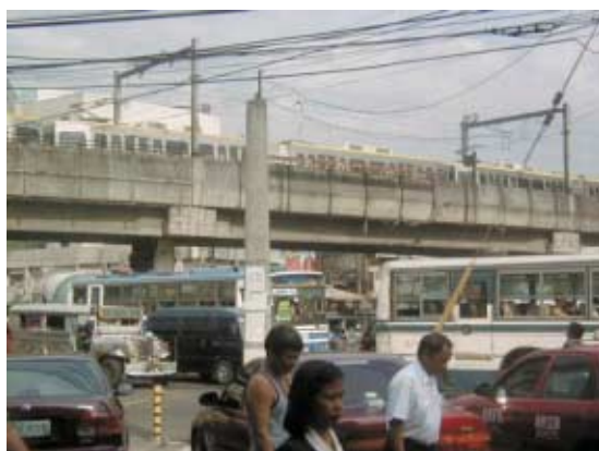
軽量高架鉄道（エドサ通りと交差する地点）
