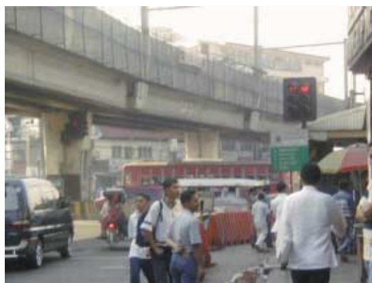
エドサータフト通りの交差点に設置された信号機
