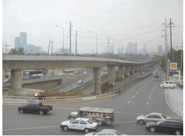
フライオーバー（エドサ アラヤ通り）
