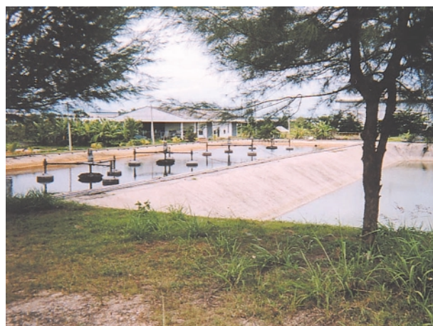
工業団地の排水処理施設
