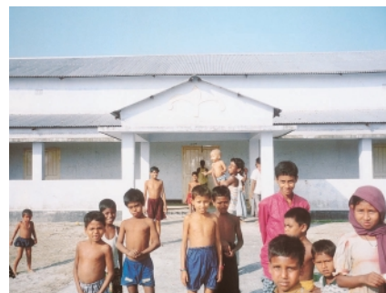
整備移転地に建設されたコミュニティーセンター
