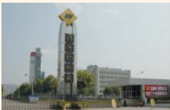
渭河化学肥料工場
