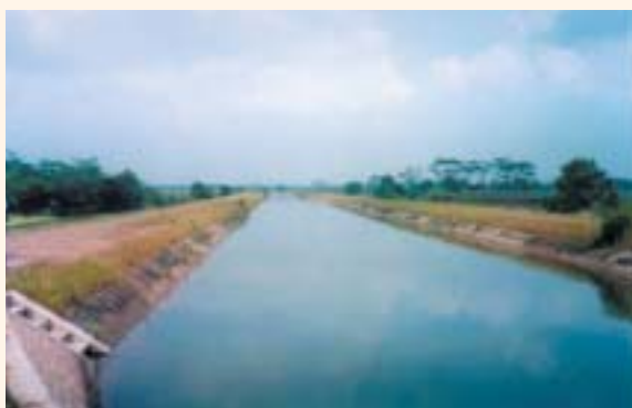
本事業により建設された灌漑水路
