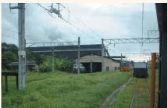
本事業により整備された鉄道
