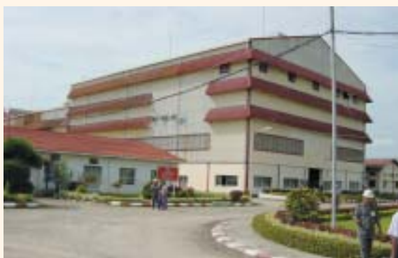
本事業により建設された砂糖工場
