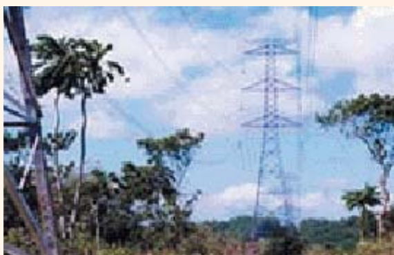
本事業により建設された送電線
