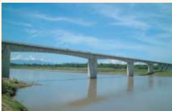
本事業により建設された橋梁（ナギリアン橋）
