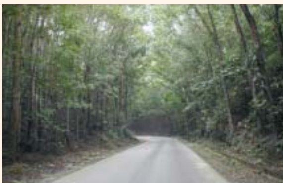
本事業により舗装された国道
