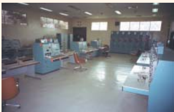
本事業により建設されたオペレーションセンター
