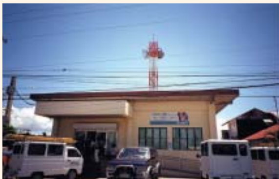
本事業により建設された電話交換局
