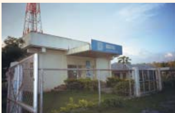
本事業で建設された交換局
