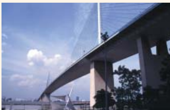
本事業により完成したチャオプラヤ河の斜長橋
