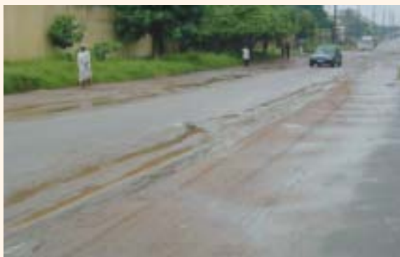
本事業による舗装道路
