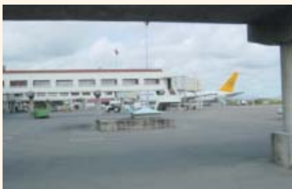
本事業により整備されたモンバサ空港
