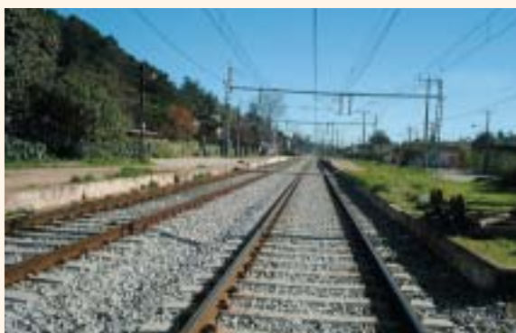
修復後の軌道・架線（バルパライソ通勤線）
