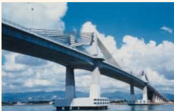
本事業により建設された第2マクタン橋
