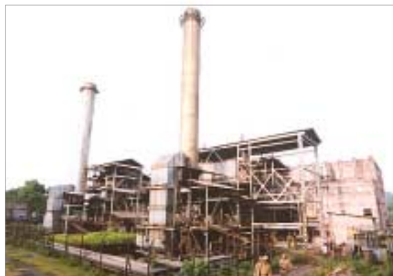
チャンドラプール火力発電所全景
