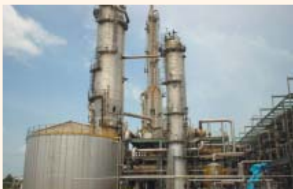
建設されたアンモニア・プラント
