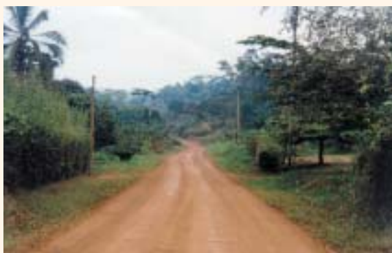
補修された地方道路
