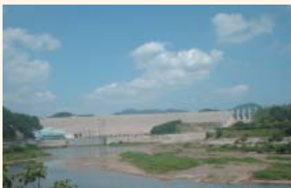
臨河多目的ダム
