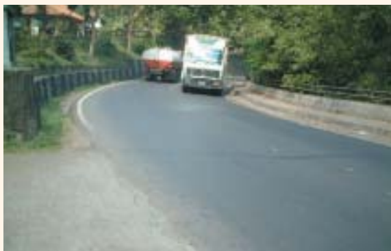
本事業により修復された道路
