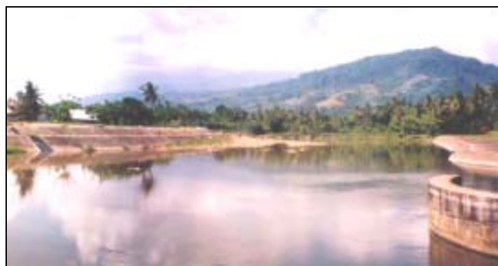
アラウ川・放水路の分流堰
