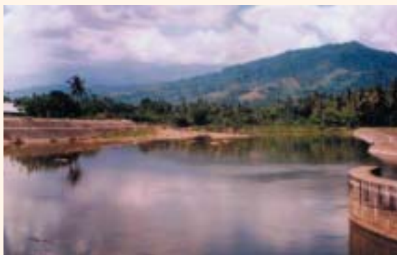
アラウ河の分流点と放水路
