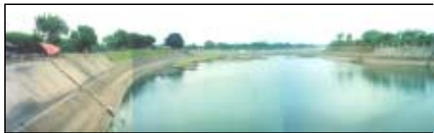
レンコンダムにおける上流の全景
