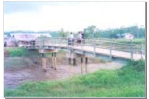
図6：修繕された橋
