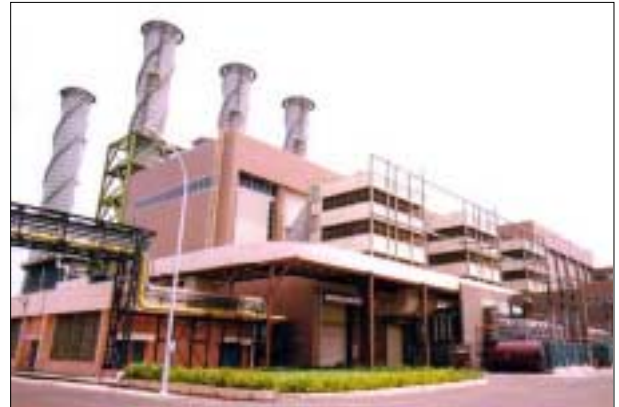
ガンダール火力発電所
