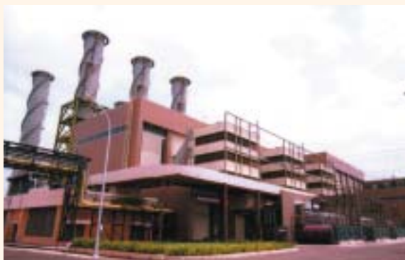
本事業により建設された火力発電所
