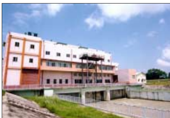
テースタ用水路水力発電所 3号機
