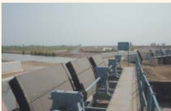
パットフィーダー水路
