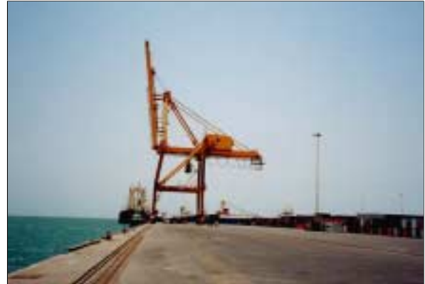
サイト写真：第七バース・コンテナクレーン
