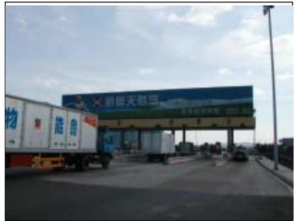
サイト写真：膠州湾高速道路の管家楼料金所
