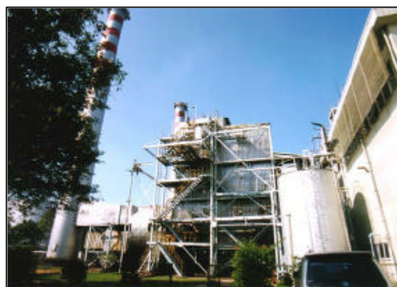
プリオク火力発電所 3 号機
