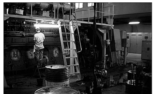
図-3: 上部オーバーホール中の発電機 (アンパナン発電所)
