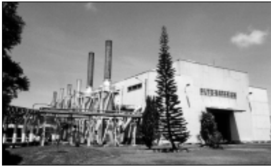
図-2: バリグパパン発電所
