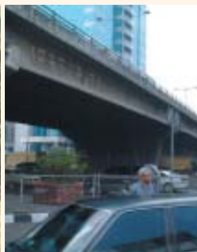
ジャカルタ市内高架橋
