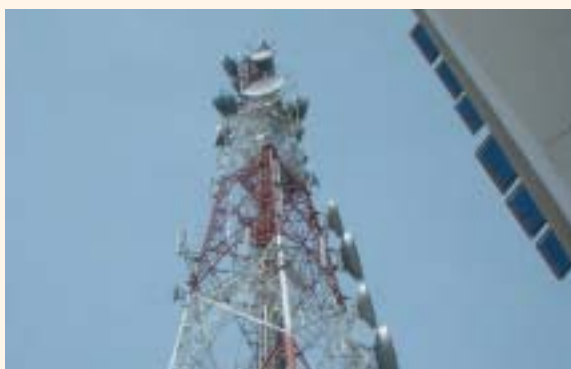
本事業により建設された伝送タワー（アユタヤ）
