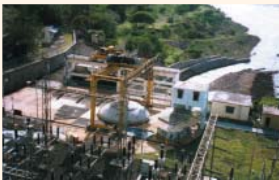
本事業により建設された水力発電所
